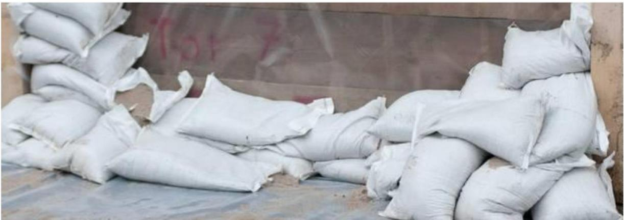
Es sind die Klassiker unter den Hochwasserschutz Systemen. Allerdings unterscheiden Sie sich deutlich in ihrer Machart und dienen unterschiedlichen Zwecken. Für den statischen Wasserdruck (See) sind sie nur bedingt geeignet. Bei einem längeren Hochwasserpegel wird der Sand langsam aufgeweicht und der Schutz lässt relativ schnell nach.
